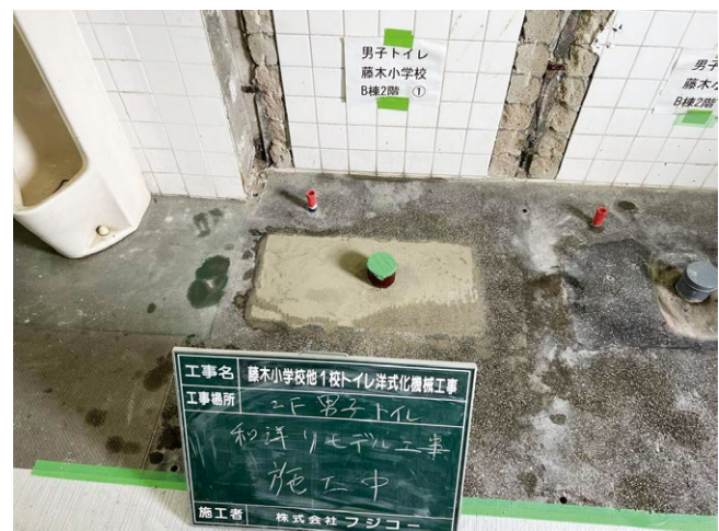
図 超速硬モルタル硬化時の様子
