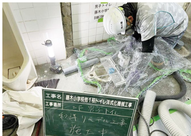
図 和便カッター使用の様子（グローブバック養生）
