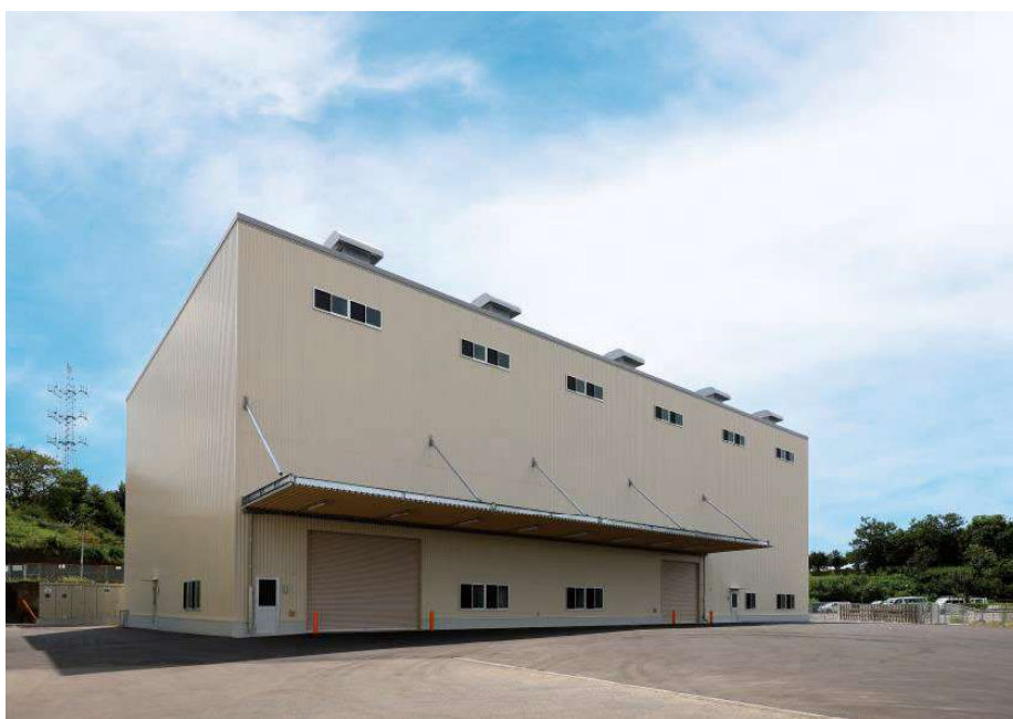
図 山陽工場の新棟全景
