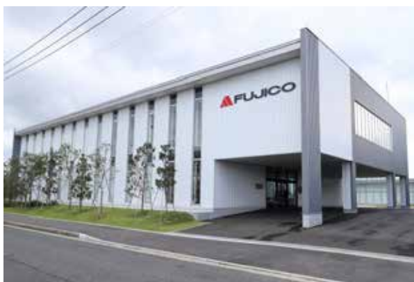
写真2 技術開発センター 研究棟
