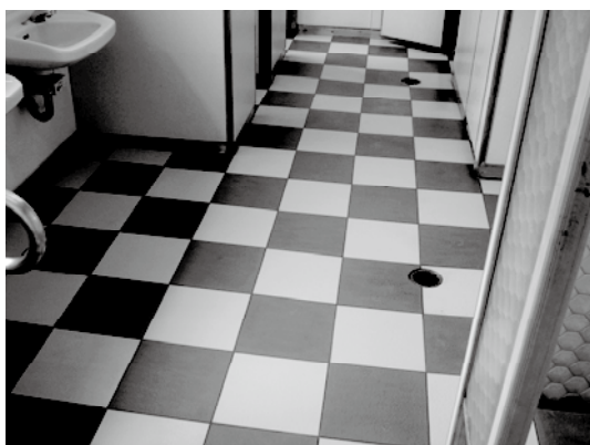
図7 モノレール平和通り駅女子トイレでのタイル施工例
