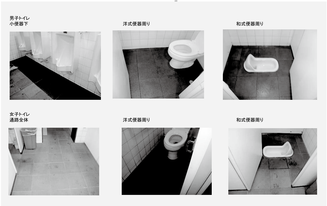
図9 JR小倉駅へのMaSSCシールドタイル施工状況
