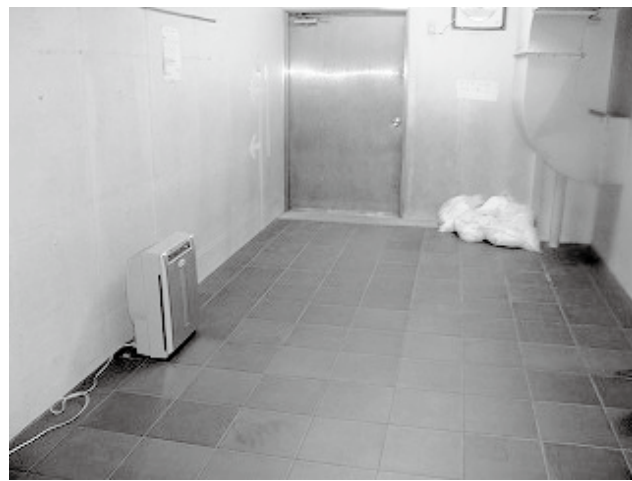
施工後：MaSSC シールドタイル
