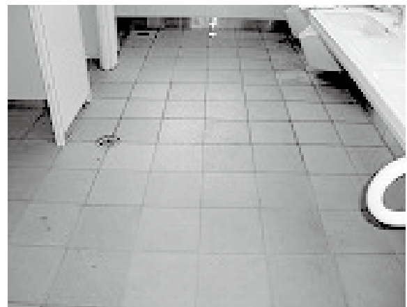
図8 知的障害者施設へのタイル施工状況
