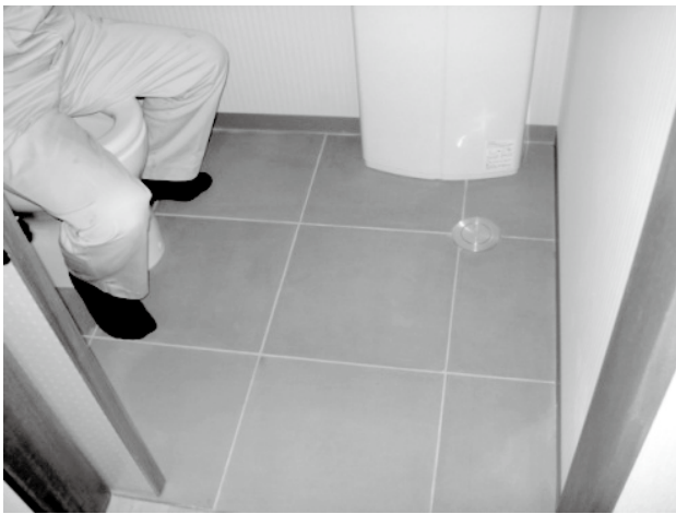
図2 MaSSC シールドタイル施工状況
