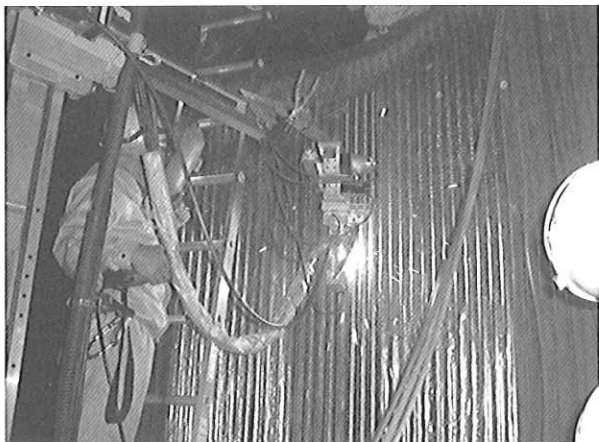
写真-3 A製鉄所の現地肉盛状況
