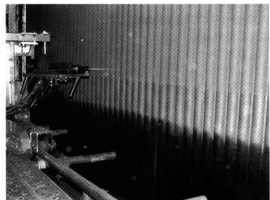
図-10 自動トラバース装置外観写真
