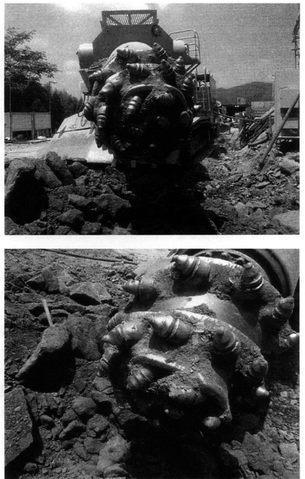
図17 掘削機(ブームヘッダー)で掘削している様子
