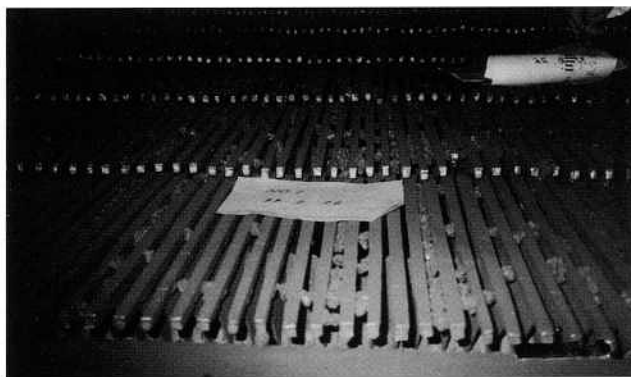
図-17 グリズリーバーの使用状況
