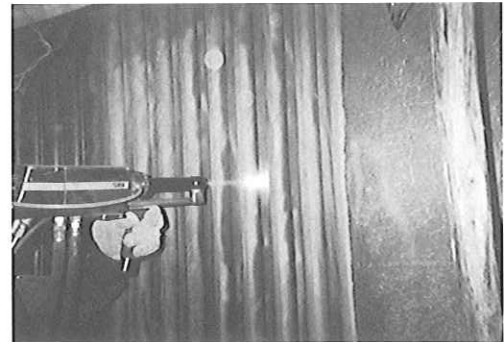
(4) 既設流動床ボイラー火炉壁へのHVOF A溶射
