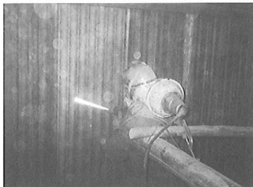
(3) 既設重油炊きボイラー火炉壁へのHVOF B溶射
