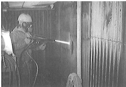
(2) 既設微粉炭炊きボイラー火炉壁へのHVOF A溶射
