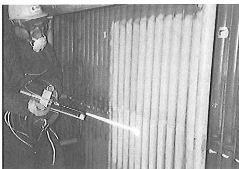
(1) 新設微粉炭炊きボイラー火炉壁へのHVOF A溶射
