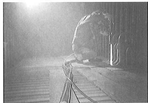
(3) 既設微粉炭炊きボイラー過熱器へのHVOF A溶射
