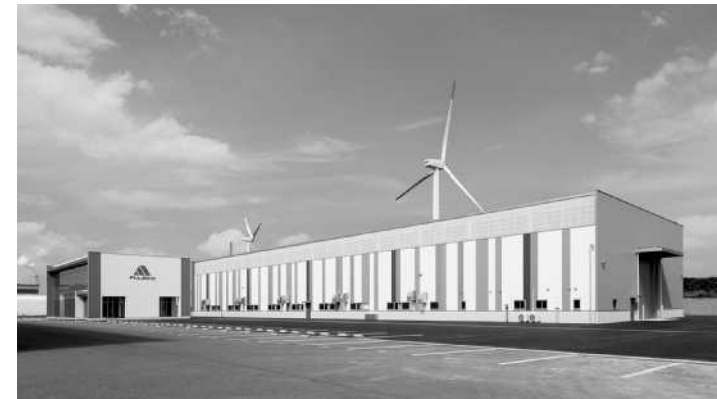
4月に完成した若松製第2工場
