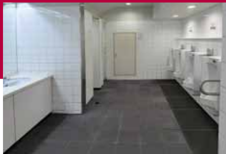
光触媒タイルが設置されたJR小倉駅構内トイレ
